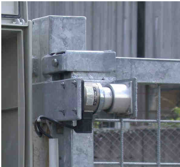
Detail: Schliessmechanismus mittels Magneten
